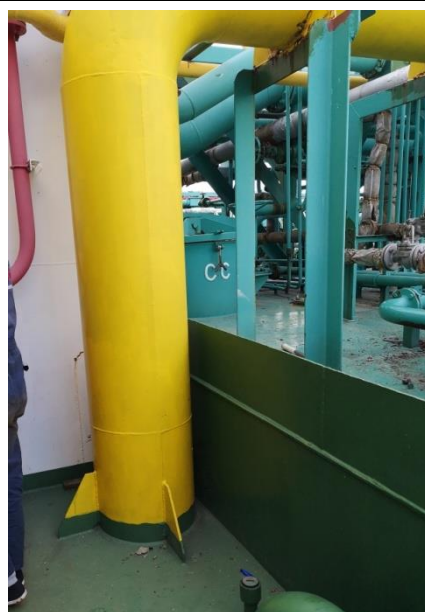
泵舱通风管根部
