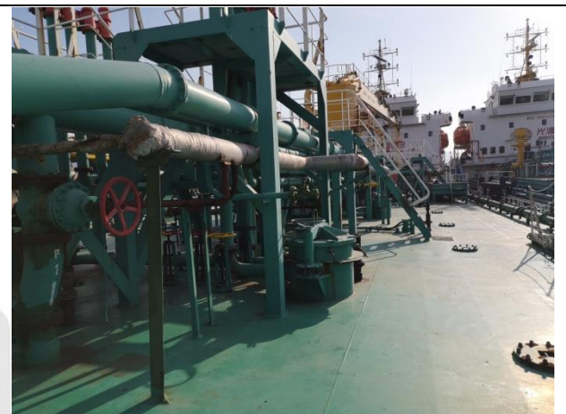
甲板导热油管路
