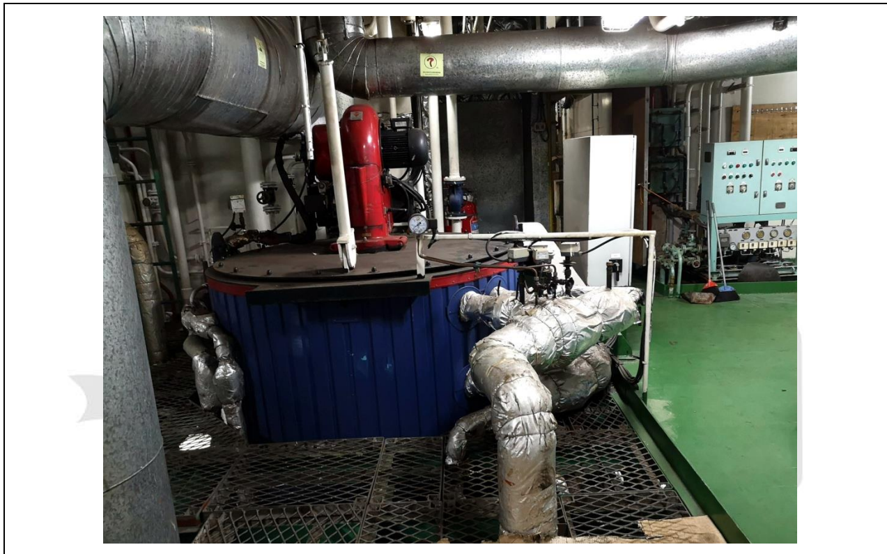
锅炉顶部点火装置
