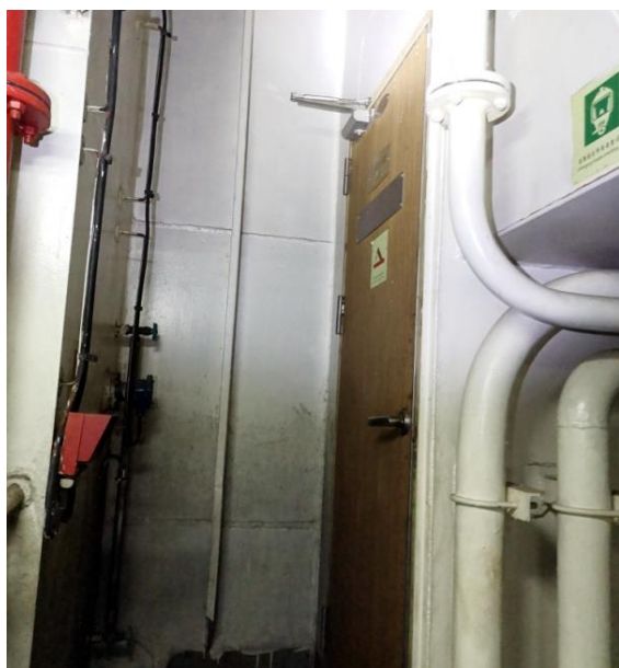
机舱脱险通道自闭门
