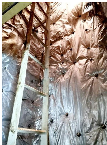
机舱脱险通道内设施
