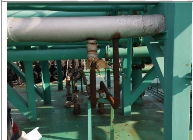
甲板消防管路
