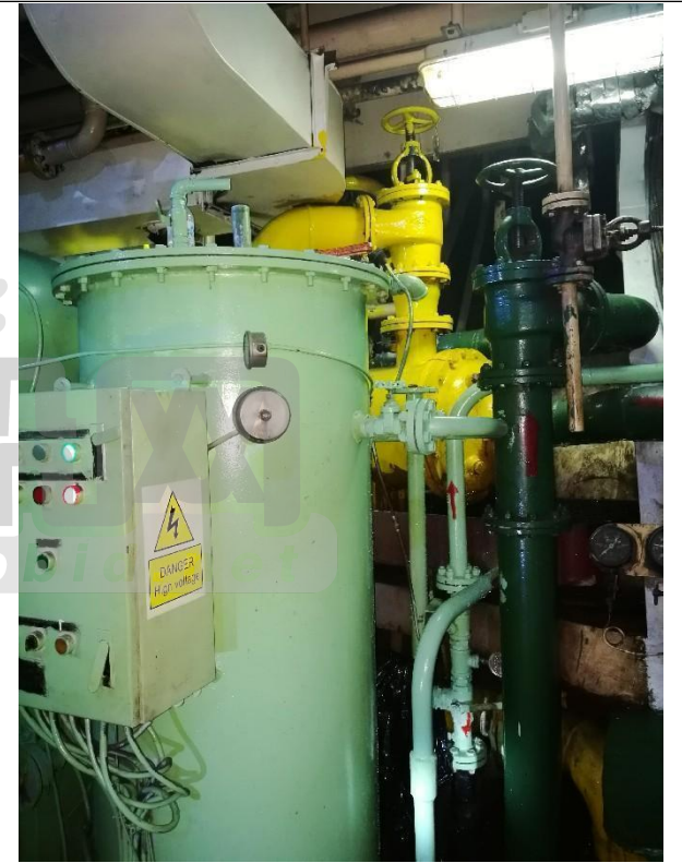
油污水处理装置
